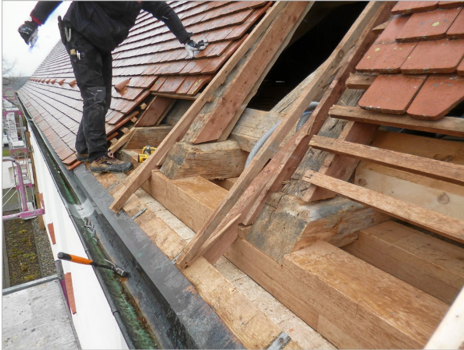
Süd, neue mehrteilige Mauerlatten S 11 bis S 13
