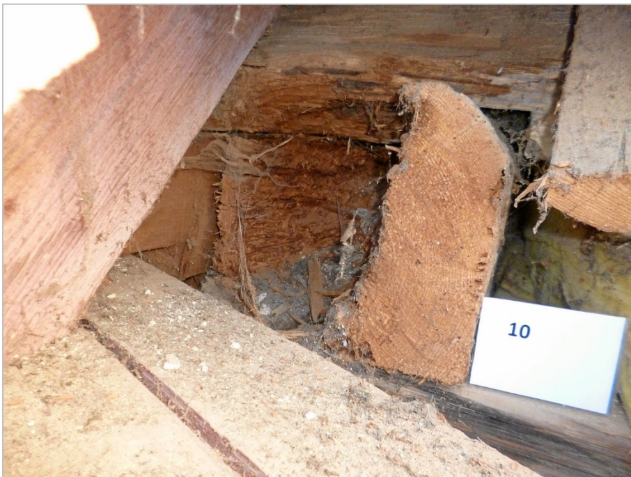
S 10: zerstörter Balkenkopf
