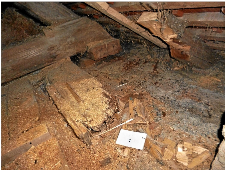
S 1: Komplett zerstörter Balkenkopf und zerstörte Mauerlatte
