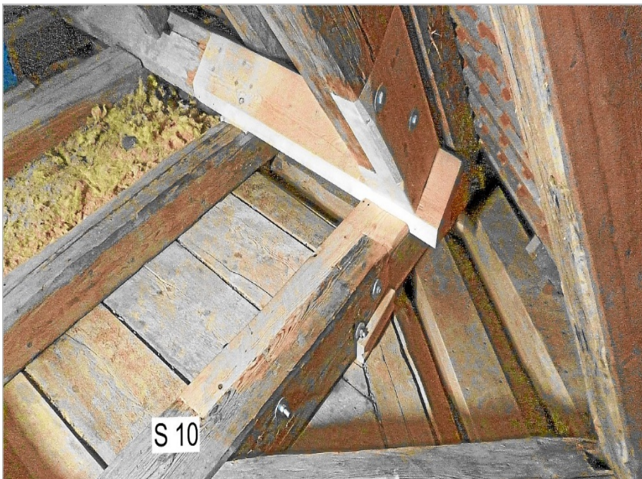
Sanierungspunkt 10 nach Abschluss der Sanierungsarbeiten mit neuer Mauerlatte, Balkenprothese, Strebenprothese und Bundschwelle.
