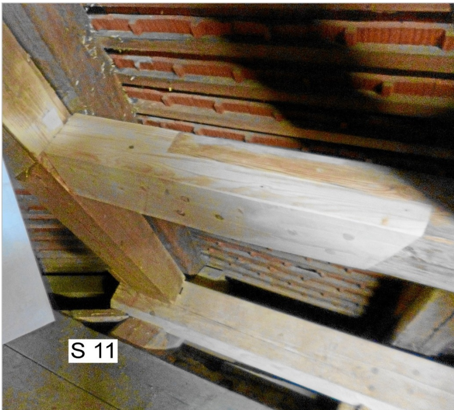
S 11 Ergänzung Riegel Windverband einschließlich kraftschlüssiger Anschluss an Bundstrebe Bund VI Süd.
