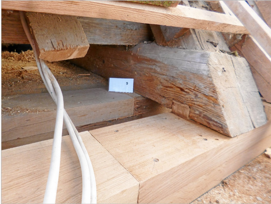
S 9: Neue, mehrteilige eichene Mauerlatte
