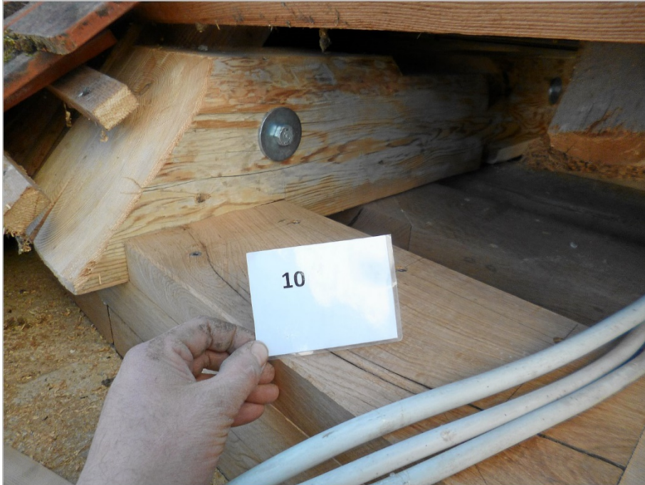
S 10: Neue mehrteilige Mauerlatte und neue Balkenkopfprothese
